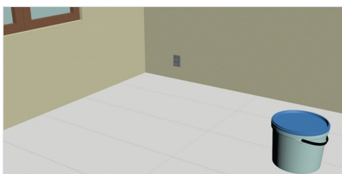
Gereinigte und grundierte Fläche – bereit für den Oberbelag.
